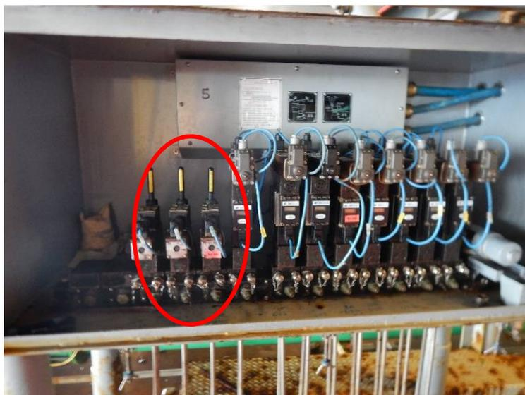
Figura 6 – Acionamento de válvula por meio de alavanca no *upper deck*
